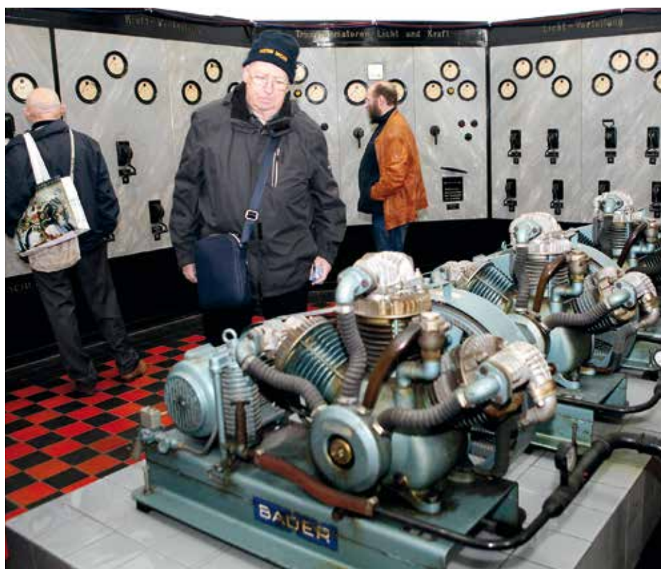
Besonders die männlichen Teilnehmer der Führung begeisterten sich für den beeindruckenden Heizungssaal, der mit Marmor ausgekleidet ist. Im Vordergrund sind alte Generatoren zu sehen.
